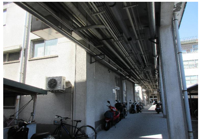
旧図書館（現資料室）と渡り廊下 現在の姿
